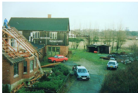
Hedensted Trævarefabrik brydes ned
