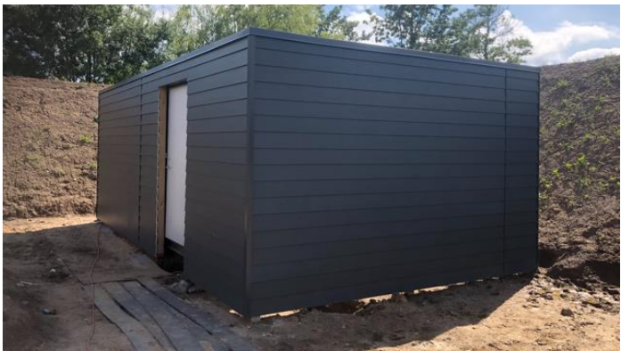
Blokvarmecentral 249 KW luft / vand varmepumpe.
